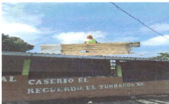
Foto1: Sustitución de lámina, por lámina troquelada aluzinc calibre 26. En corredor, baños y bodega
