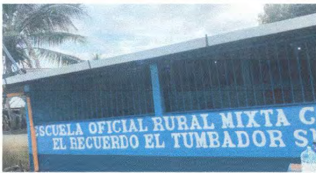
Foto 7: Pintura en muros exteriores e interiores
