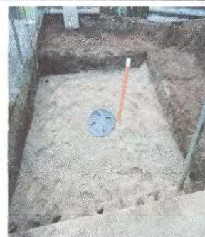
Foto 6: Sustitución de fosa séptica por biodigestor de 1300 Lts. Y Sustitución de tubería PVC linea principal aguas negras
