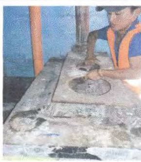
Foto 5: Mantenimiento a estufa rural, Sustitución de plancha de metal de 3 hornillas e Instalación de azulejo en estufa rural
