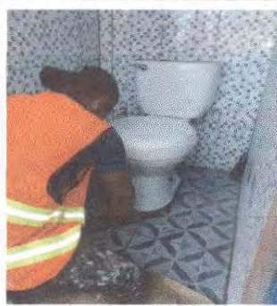
Foto 4: Sustitución inodoro, Sustitución de azulejo y Sustitución de piso cerámico con nivelacion de base (baños)
