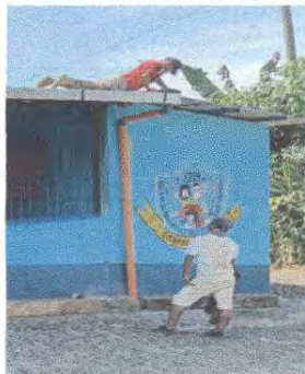
Foto 3: Sustitución de canal de pvc y Sustitución de bajada de agua pluvial de metal por tubo PVC 3"
