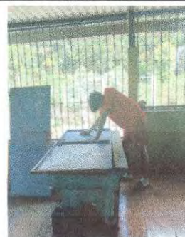
Foto 2: Mantenimiento a estructura (lijado, cambio de tubo , cepillado, aplicación de pintura) y mantenimiento a portones
