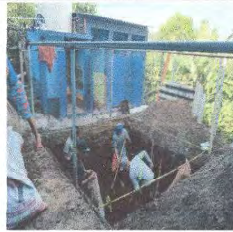
Foto 6: Sustitución de fosa séptica por biodigestor de 1300 Lts. Y Sustitución de tubería PVC linea principal aguas negras
