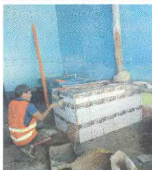
Foto 5: Mantenimiento a estufa rural, Sustitución de plancha de metal de 3 hornillas e Instalación de azulejo en estufa rural
