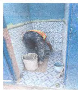
Foto 4: Sustitución inodoro, Sustitución de azulejo y Sustitución de piso cerámico con nivelacion de base (baños)
